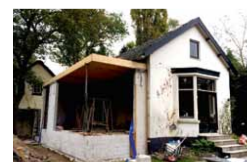
Het oorspronkelijke huis (boven), daaronder de verbouwing in volle gang
