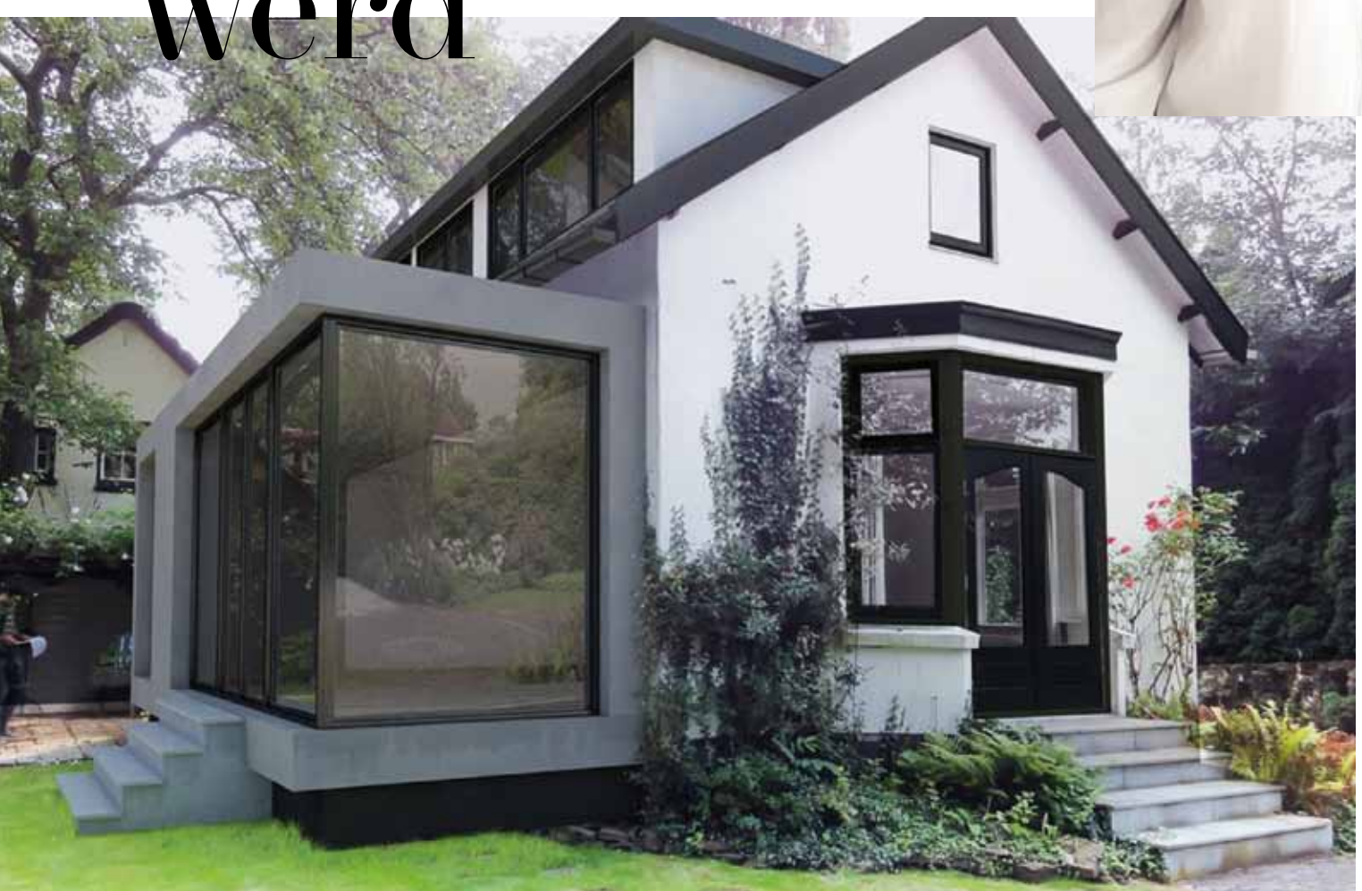
Het huis met de aanbouw van 3 meter
